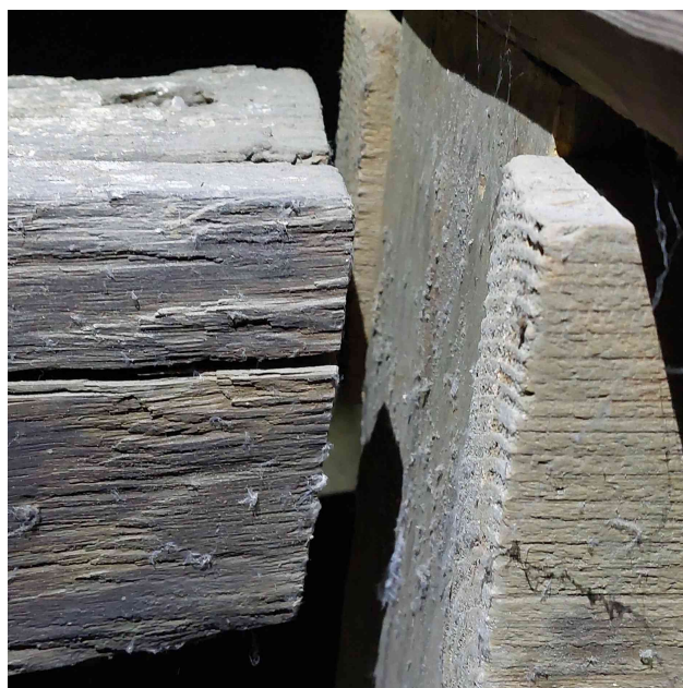
Obr. 22: spoj C, nutno propojit
