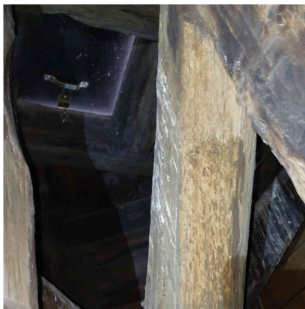
Obr. 24: napadení červotočem
