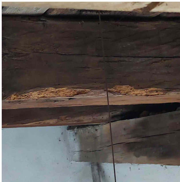
Obr. 14: ST 2, napadení červotočem
