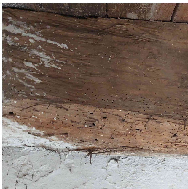
Obr. 11: ST 5, napadení červotočem
