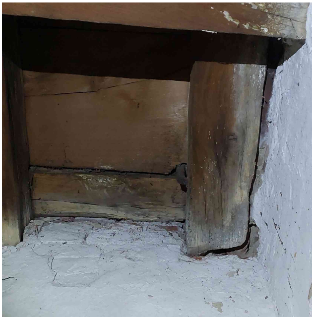
Obr. 15: ST 1, degradace trámovkou
