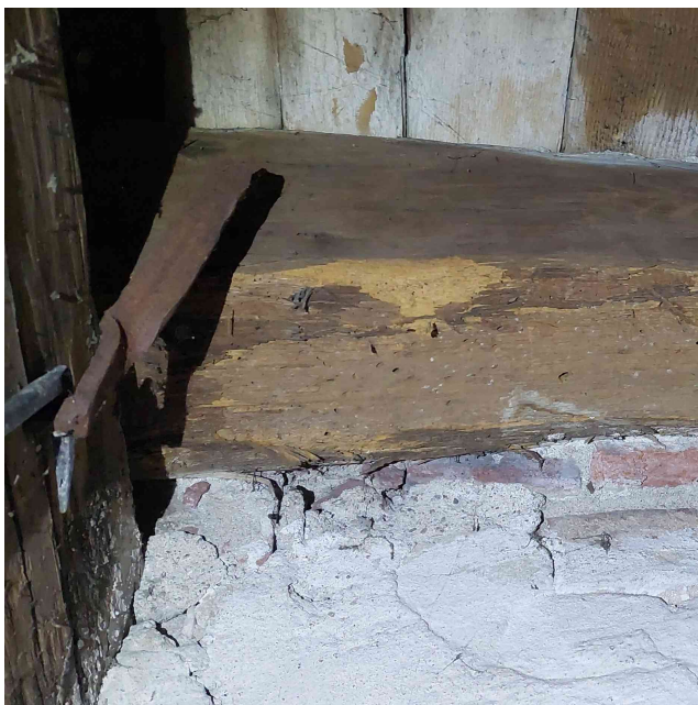
Obr. 17: ST 1, napadení červotočem
