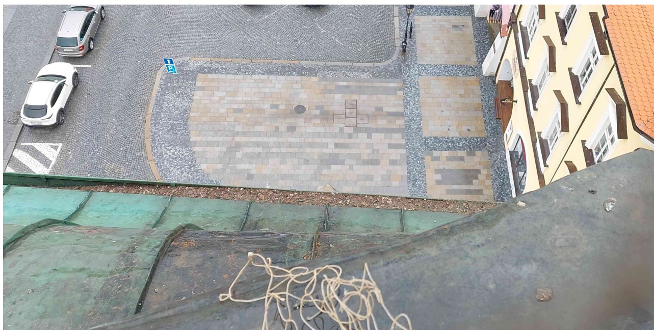
Obr. 33: okap plný holubího trusu
