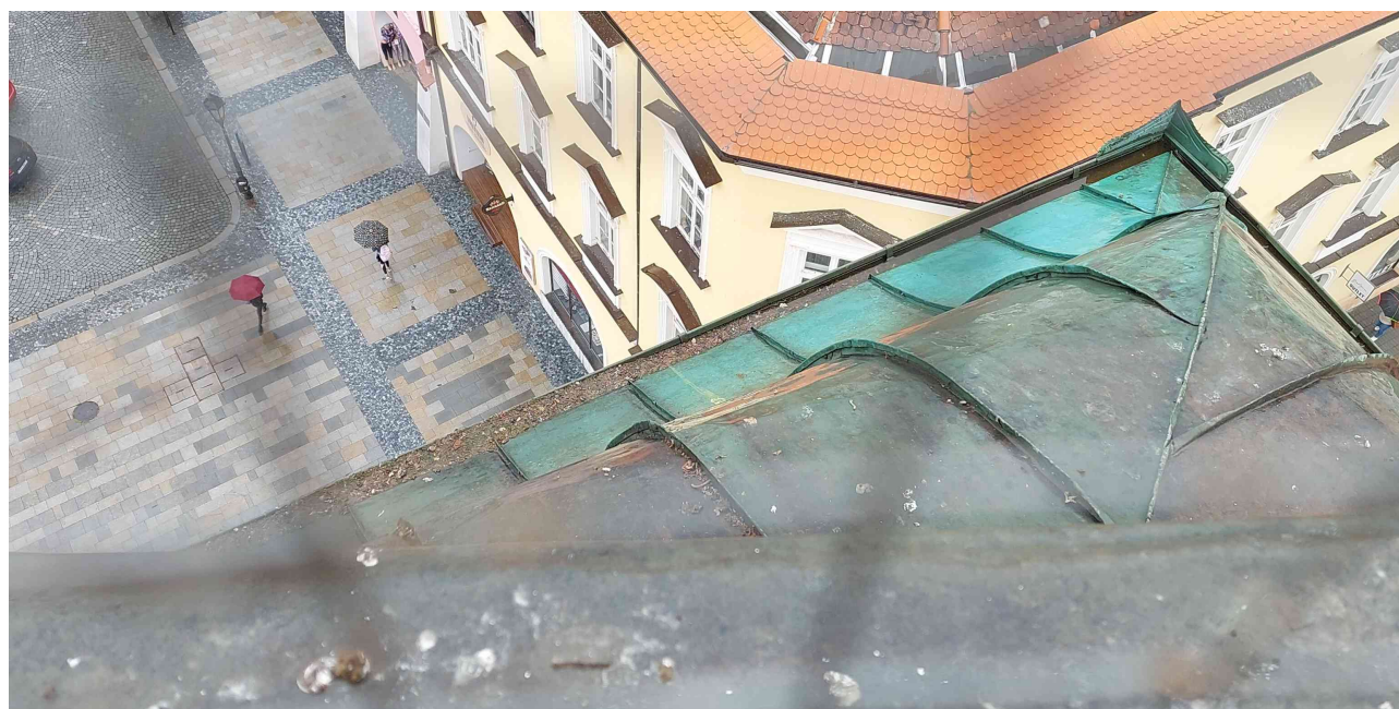
Obr. 34: okap plný holubího trusu
