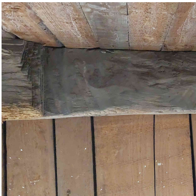
Obr. 8: ST 2, mechanické oslabení
