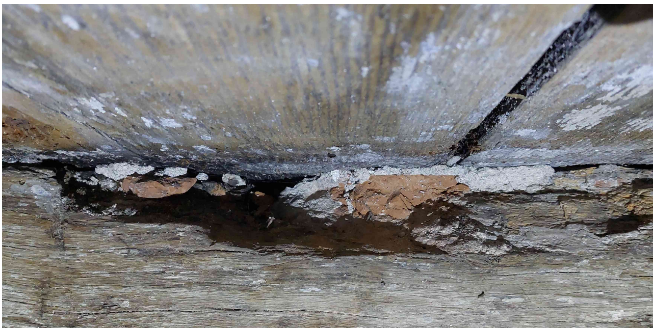
Obr. 19: ST 4, napadení trámovkou
