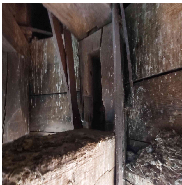
Obr. 27: snížení trámu pro zvon
