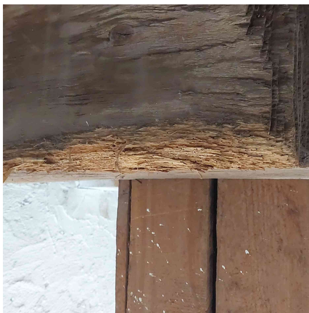
Obr. 9: ST 2, napadení červotočem
